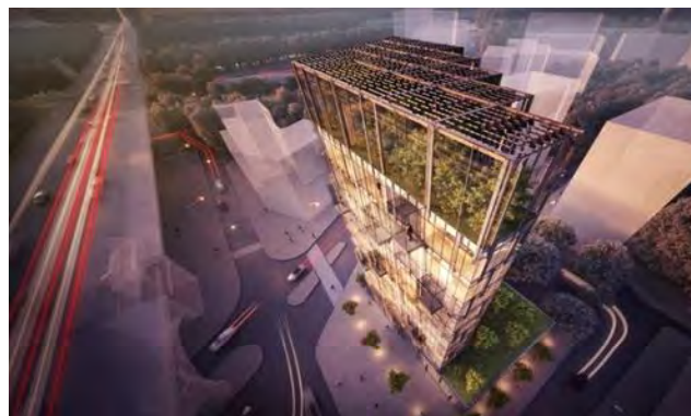
Eco Warsaw Tower, projet BXB, actuellement en chantier
