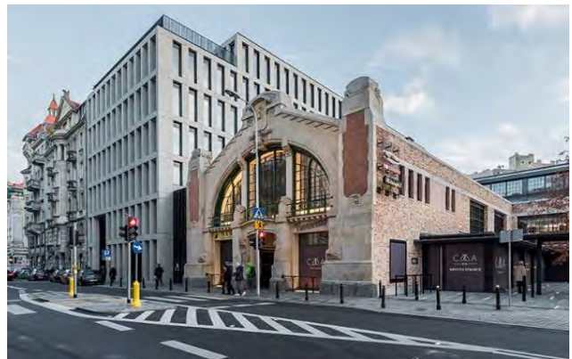
JEMS : Halles de Koszyki à Varsovie : Transformation et réhabilitation
